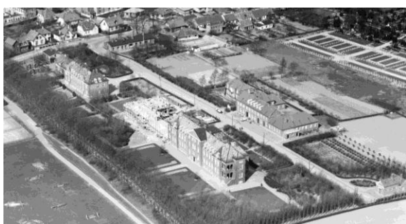
Sygehuset ca. 1938 med den medicinske afdeling under opførelse. Til venstre Skovstien og den selvstændige epidemiafdeling. Til højre overlægevillaen, køkken- og vaskeribygningen og kapellet. Sylvest Jensen, Det kongelige bibliotek.
